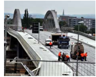
An der Waldschlösschenbrücke werden die letzten Arbeiten erledigt, ehe sie am 26. August freigegeben wird.
