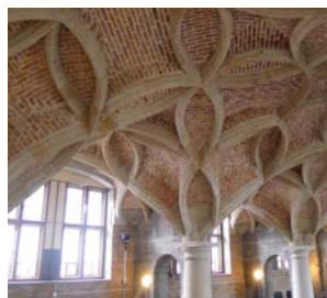
Das Schlingrippengewölbe in der Kapelle des Dresdner Schlosses wurde vorige Woche übergeben.
