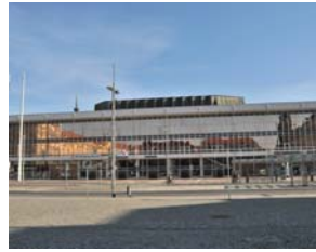
Der Kulturpalast bekommt für 81,5 Millionen Euro eine hochwertigen Konzertsaal. Foto: SachsenGAST
