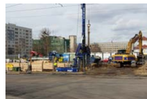
An der Wallstraße arbeiten bereits die Bagger und legen den Grund für neue Wohnungen. Foto: SachsenGAST
