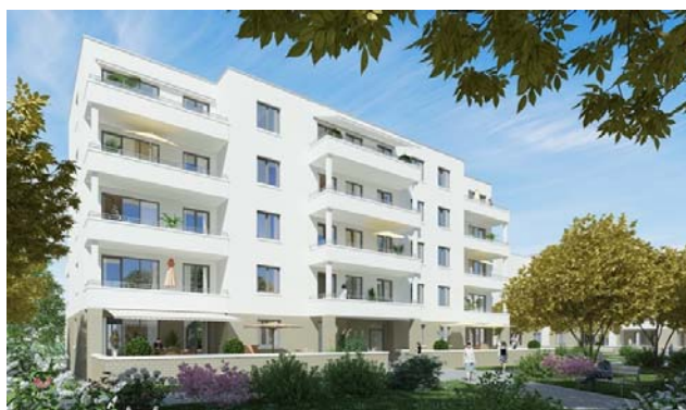
In Dresden-Striesen baut PEGASUS weitere 104 moderne Eigentumswohnungen. Am Samstag kann eine Musterwohnung besichtigt werden.
