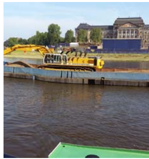
Ein Schwimmgreifer sorgt nach dem Niedrigwasser dafür, dass die Elbe wieder ihre gewohnte Tiefe hat. Foto: SachsenGAST
