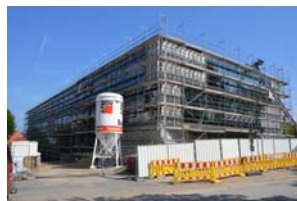
An der Nöthnitzer Straße entsteht ein Neubau für die Photophysiker der TU Dresden.
