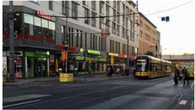
Die Haltestelle an der Kesselsdorfer Straße wird total umgebaut. Foto: Dresden-Fernsehen
